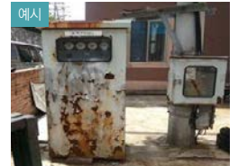
배전반 노후 및 커버 소손 * 관계자 이외에는 절대 접촉금지입니다.
